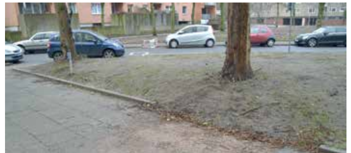
Wo das Überbrücken der Wurzeln nicht möglich ist, müssen die Rasenborde ganz weggelassen werden, wie hier am Fritz-Flinte-Ring. Auch die mit Schotter aufgefüllte Lücke im Plattenbelag ist den Baumwurzeln geschuldet.
