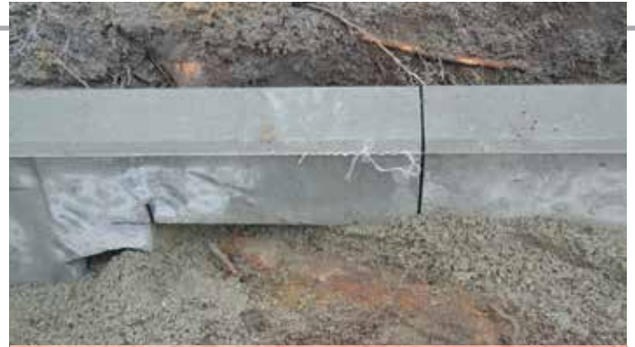
Durch eine Aussparung im neuen Bordstein wird die starke Baumwurzel überbrückt (Erich-Ziegel-Ring).
